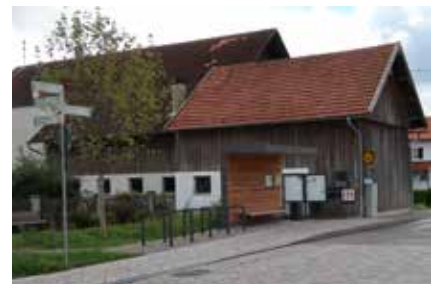
barrierefreie Übergänge + Bushalt, Denklingen
