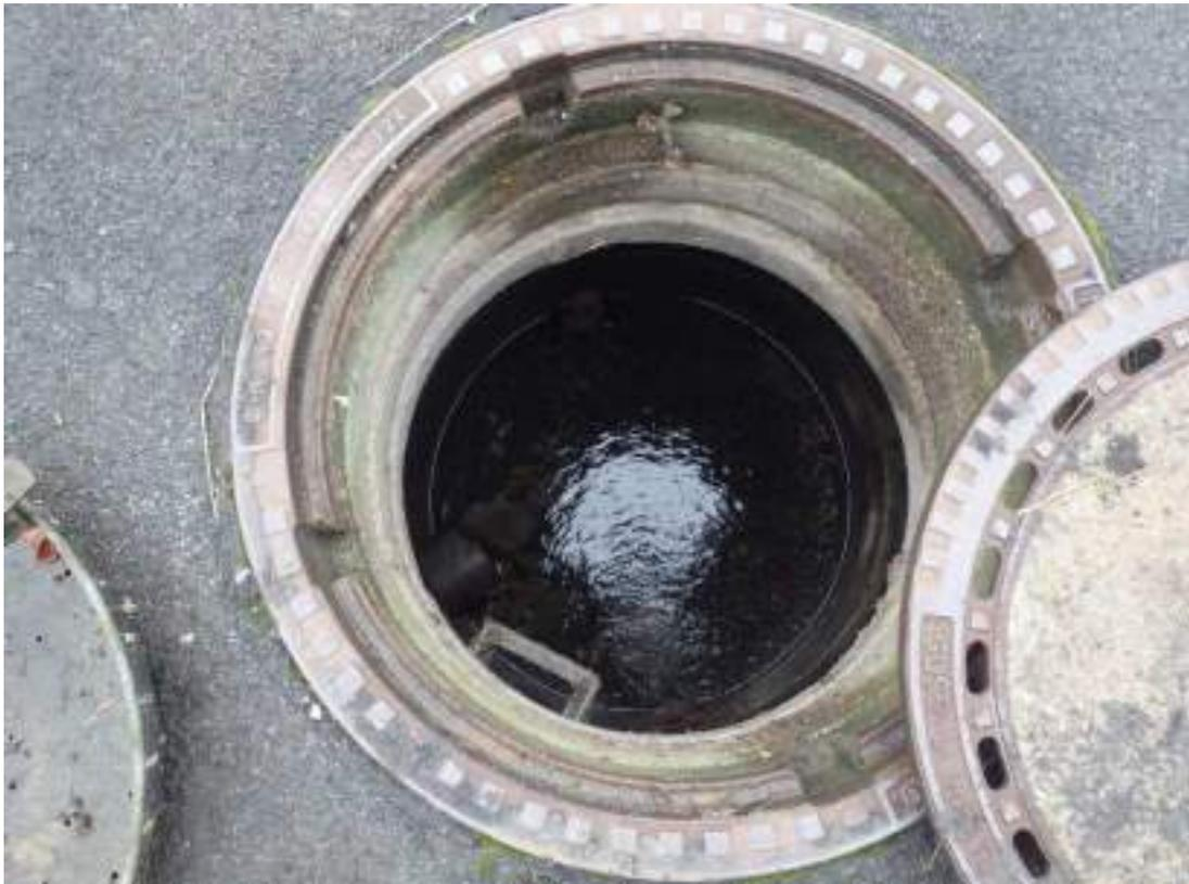
Abbildung 5: Bestehender Sickerschacht, an welchen der verrohrte Graben angeschlossen ist
