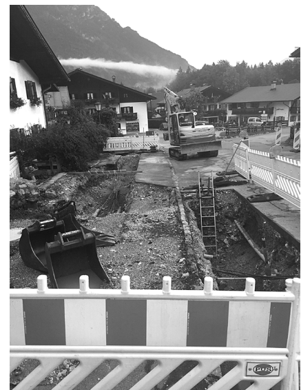
Bauarbeiten am Oberen Dorfplatz
