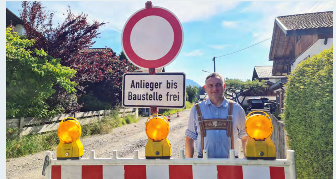
Bürgermeister Stephan Märkl bei einer Besichtigung der Straßen-Baumaßnahme „Am Krepbach“
