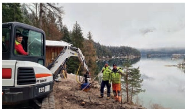
Anton Diepold (rechts) und Michael Rieger (Mitte) vom gemeindlichen Bauhof zusammen mit Niki Grasegger legen das Fundament für eine der drei Informationstafeln am Eibsee. Ebenso errichteten sie die Fundamente für die 14 Müllstationen
